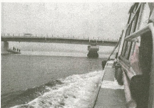
完成した森山堤開削部を船で通り初め
