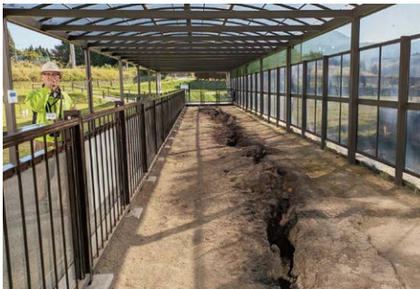
地震で亀裂の入ったミュージアムの敷地
