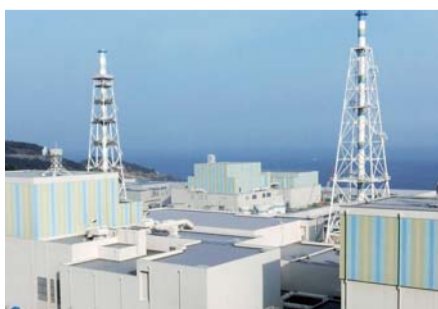
島根原発全景(中国電力提供)
