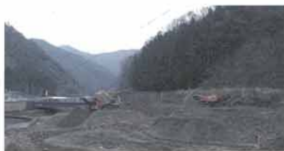
復旧工事が始まった名賀川周辺
