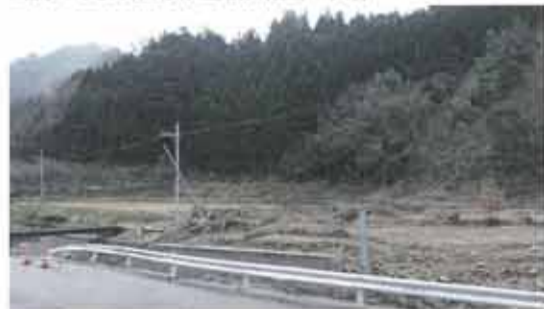
右側の崖が崩れ土砂が田や川に流れ込む
