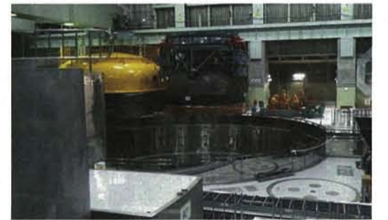
建設が進む3号機原子炉格納容器
