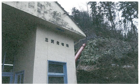
三沢小水力発電所
