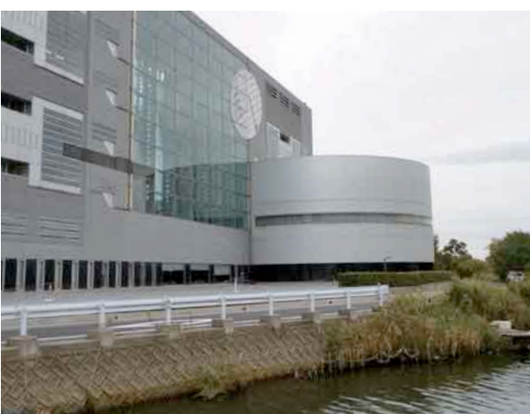
大橋川から見たくにびきメッセ
